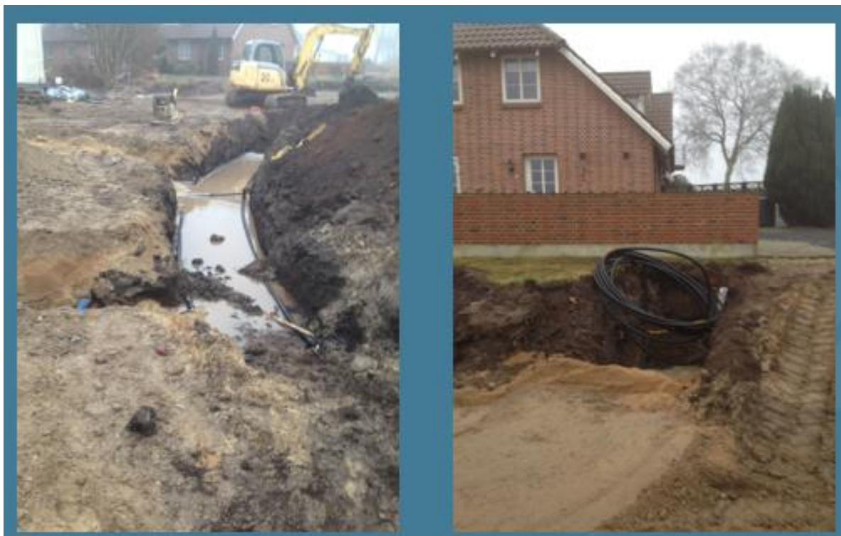
Figur 8. Rørgraven i Silkeborg.
