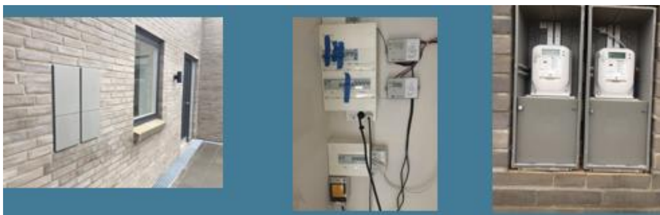
Figur 7. Bi-elmåler til varmepumpen i Silkeborg.
